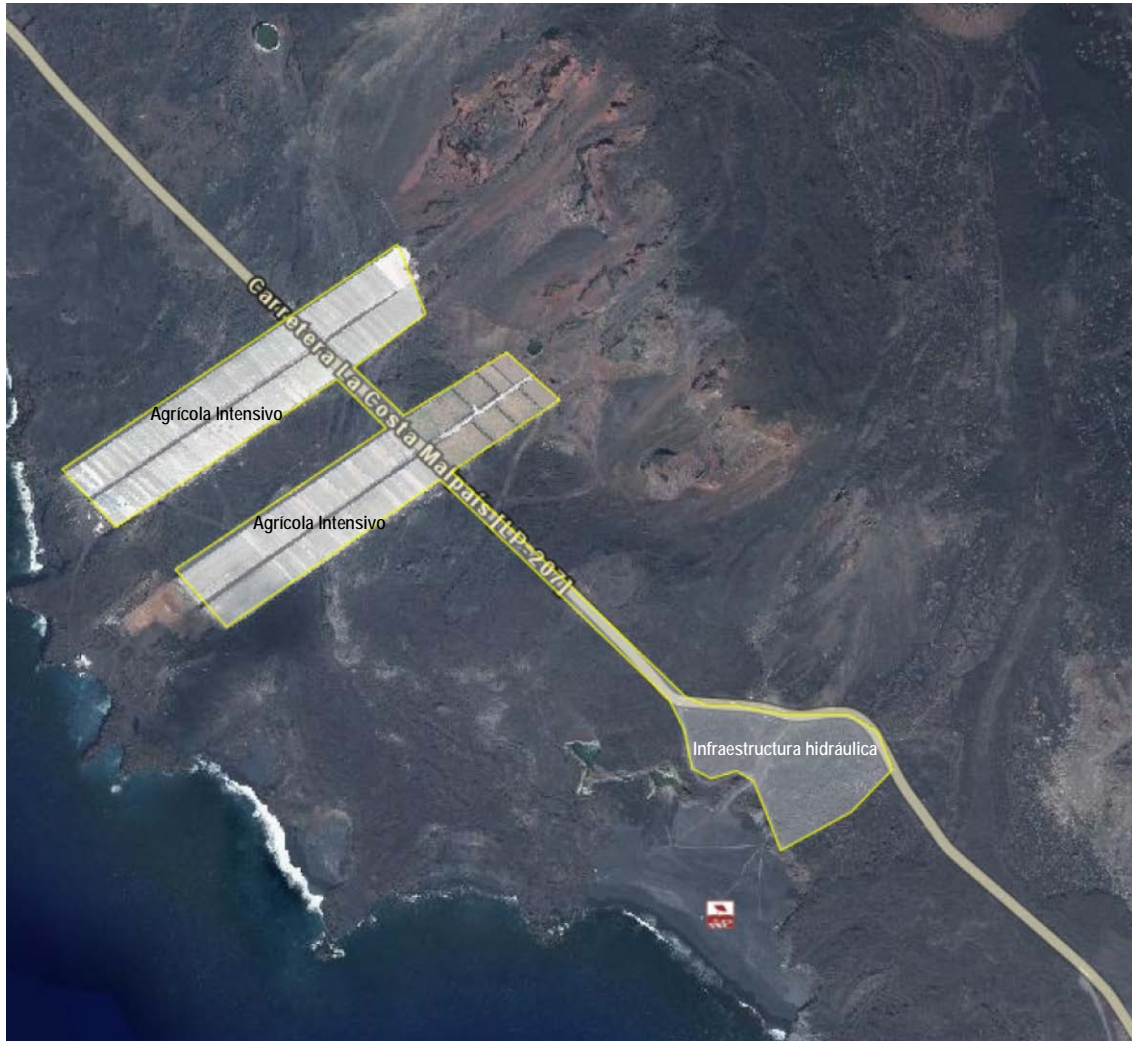
Fig.26.- Infraestructuras – Usos del suelo. (Sistema de Información Territorial de Canarias – IDE Canarias).
